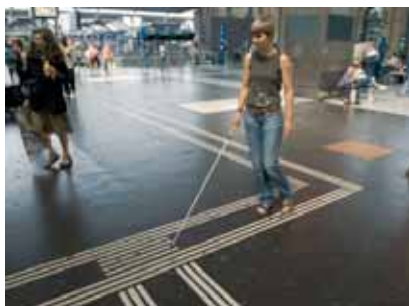
Ein Leitliniensystem ermöglicht blinden Personen sich im HB Zürich zu orientieren. Bild: Archiv SBB
